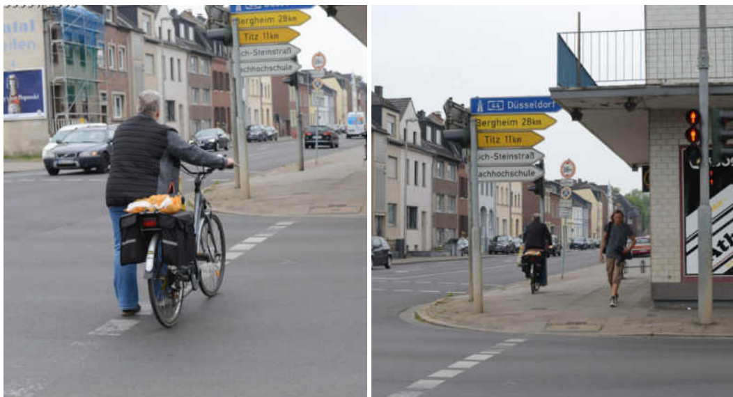
Abbildung 113: Unsichere Radfahrer schieben über die Furt und fahren über den Gehweg weiter
