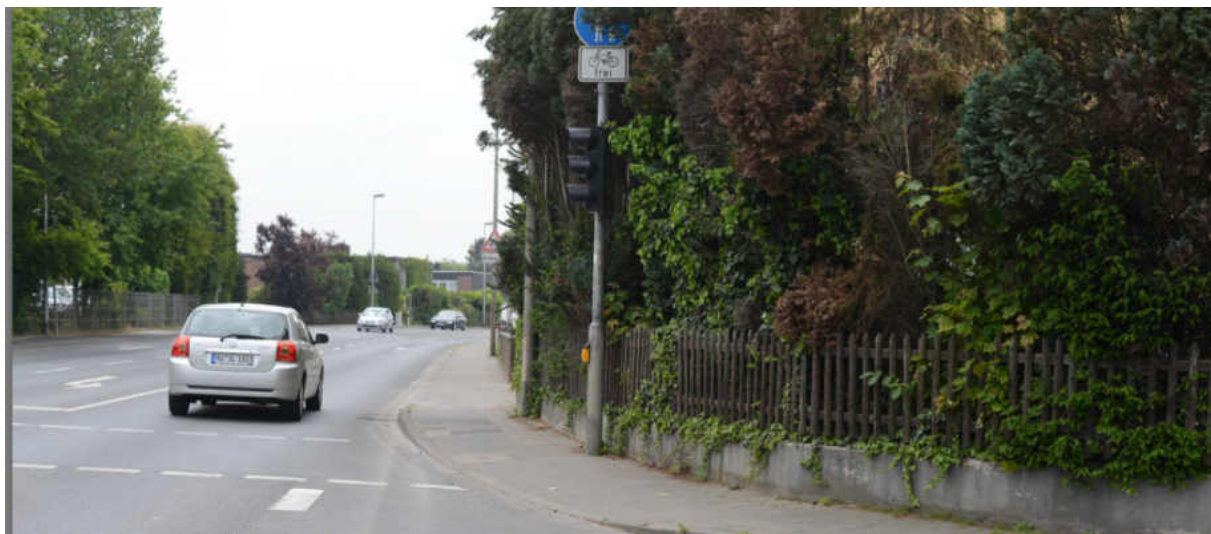
Abbildung 61 und Abbildung 62: Im Bereich des Knotenpunktes Lohfeldstraße / Ulmenweg sind die für den Radverkehr freigegebenen Gehwege ca. 1,50 m breit. Dieses Maß ist unzureichend
