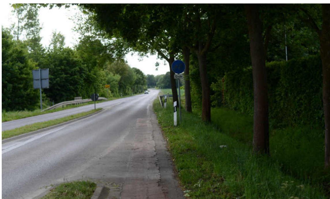
Abbildung 93: Fehlende Radverkehrsanlagen an der Kreisstraße K 6
