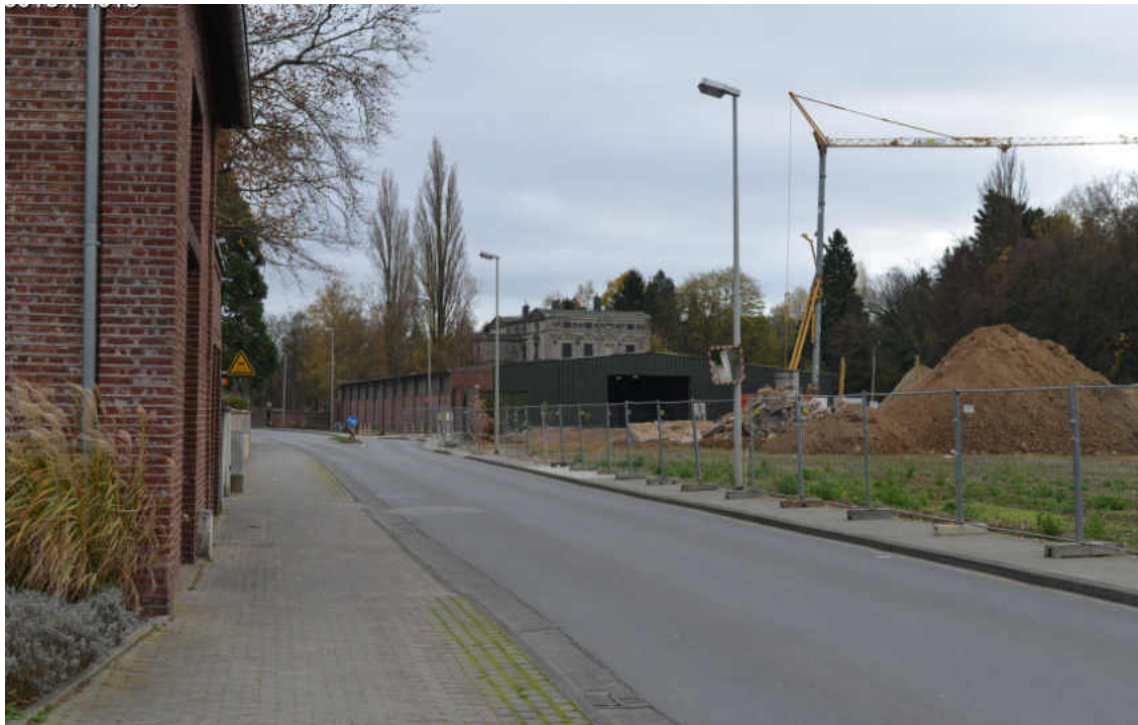
Abbildung 123: Ortsdurchfahrt im Bereich der Wellpappenfabrik mit gefährlichen Einfahrten
