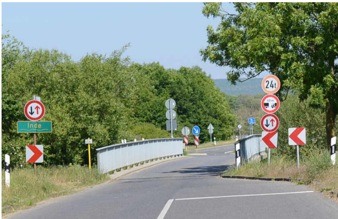
Abbildung 103: Beginn des Radweges hinter der Indequerung
