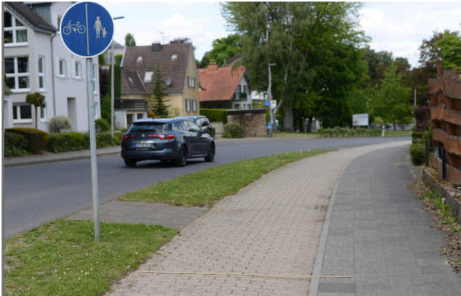
Abbildung 79: Nicht StVO-konformer Radweg in Barmen (für beide Fahrrichtungen)
