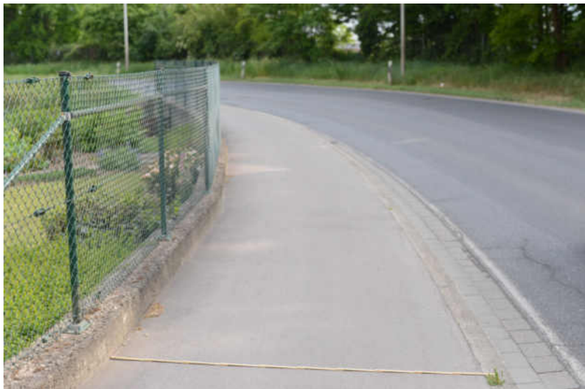
Abbildung 91: Eine Engstelle, die nicht mit vertretbarem Aufwand beseitigt werden kann
