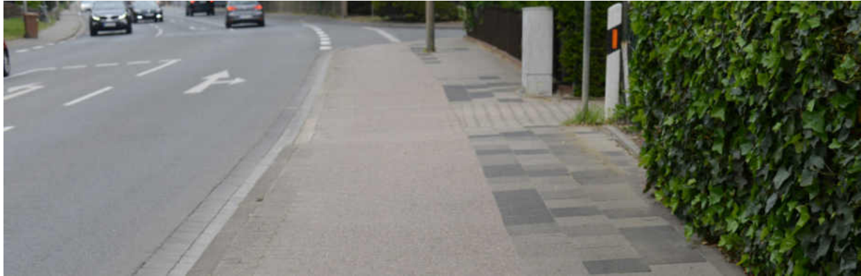
Abbildung 64: Nur am östlichen Straßenrand zwischen Alter Dürener Straße und Buchenstraße ist ein 1,50 m breiter Radweg und ein Fußweg von ca. einem Meter Breite vorhanden
