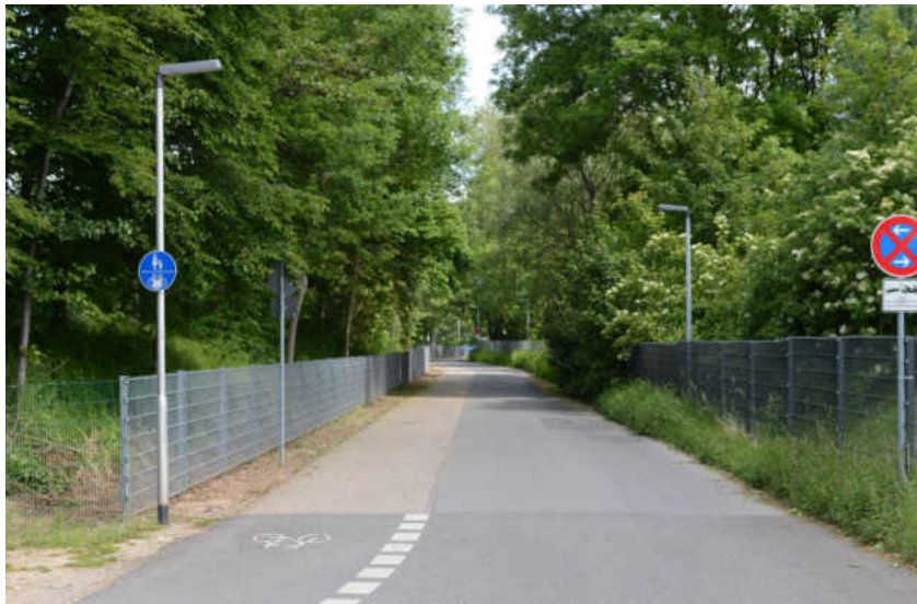
Abbildung 81: Gemeinsamer Fuß- und Radweg mit unklarer Abgrenzung zur Fahrbahn (kein Fahrbahnbegrenzungsstreifen, kein Bordstein)
