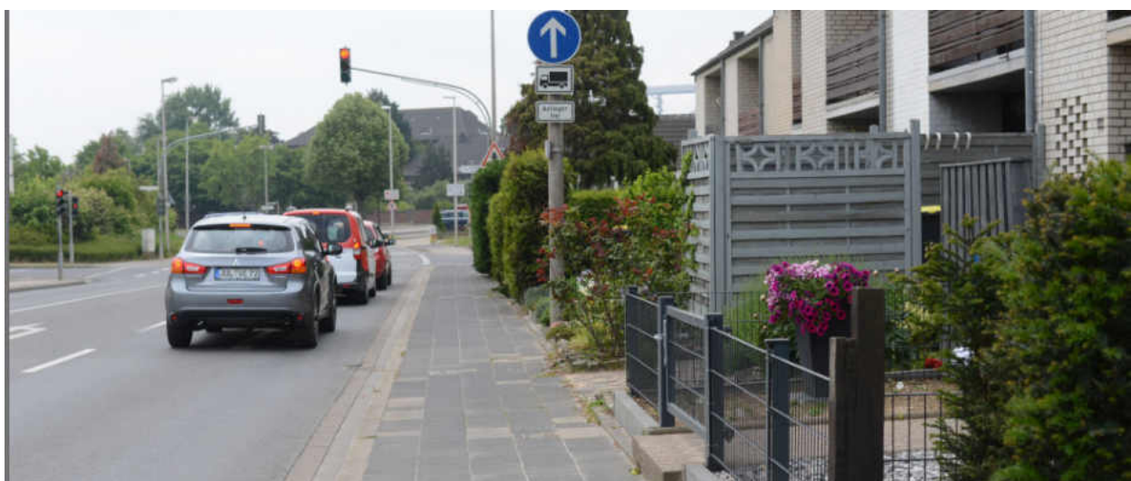
Abbildung 63: Auch am Knotenpunkt mit der Alten Dürener Straße zeigt sich der Fußweg mit seiner Regelbreite von 1,50 m
