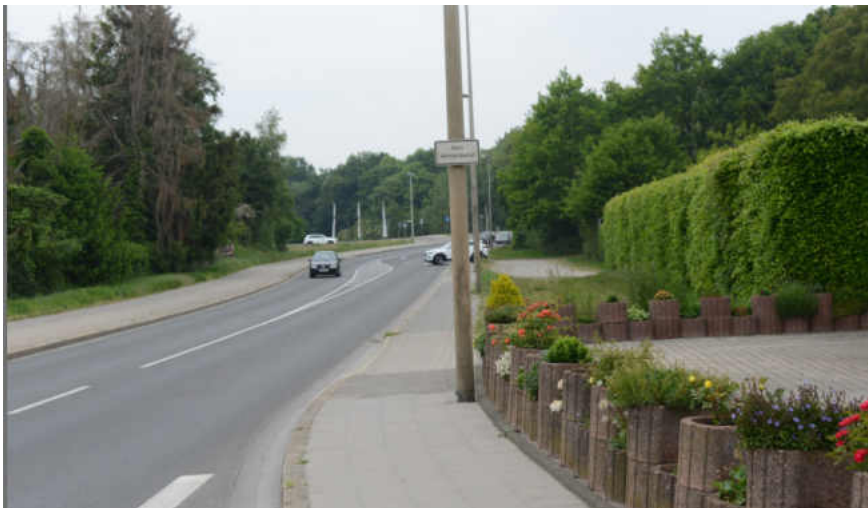
Abbildung 73: Auf der östlichen Straßenseite ist eine Verbreiterung der Nebenanlage auf 2,50m anzustreben und eine durchgehende Radverkehrsanlage zu schaffen.
