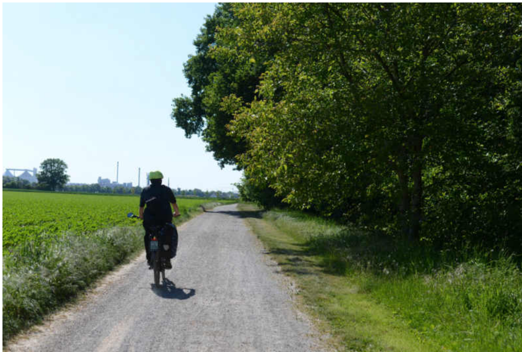
Abbildung 56: Der vorhandene Schotter- und Splitweg ist teils schadhaft und unkomfortabel zu befahren. Staubentwicklung bei Trockenheit, Dreck bei Nässe dämpfen das Fahrerlebnis
