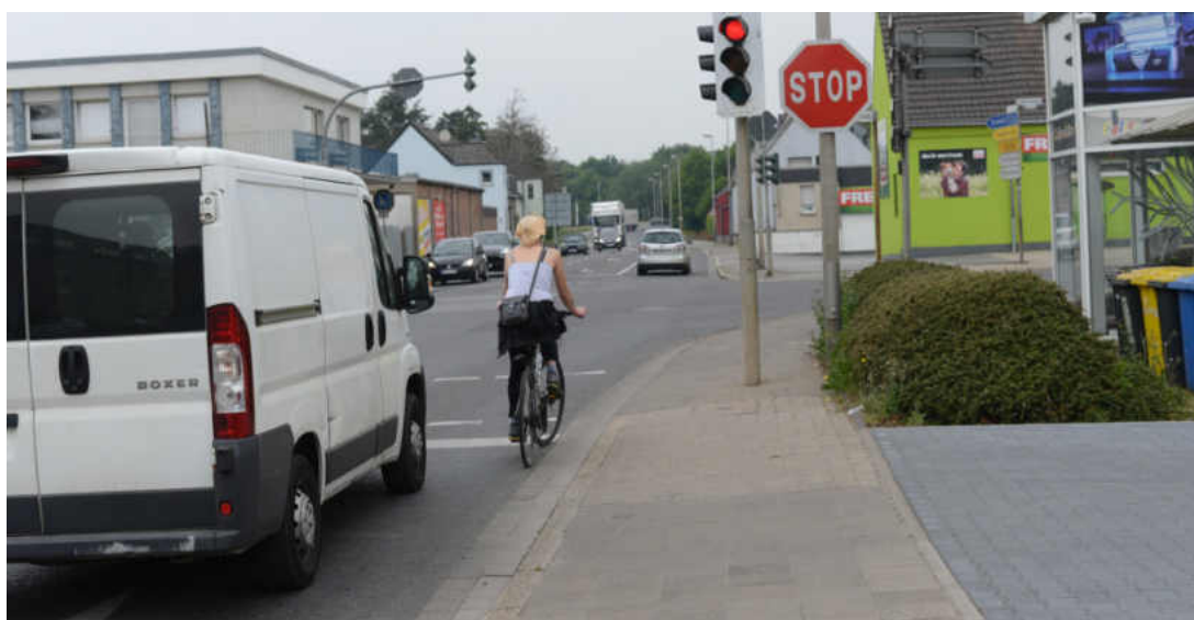
Abbildung 59: Es ist eine nicht zufriedenstellende Situation durch nicht ausreichende Abstände zwischen den Verkehrsteilnehmern zu erkennen. Auch hier wäre im Bereich des Begleitgrüns Raum für eine deutliche Verbreiterung der Nebenanlagen vorhanden
