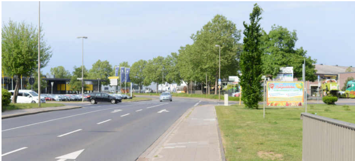
Abbildung 67: Von Süden kommend muss von der Dürener in die Dürener Straße indirekt abgelenkt werden. Es gibt keine Hilfen, Aufstellflächen oder Ähnliches.
