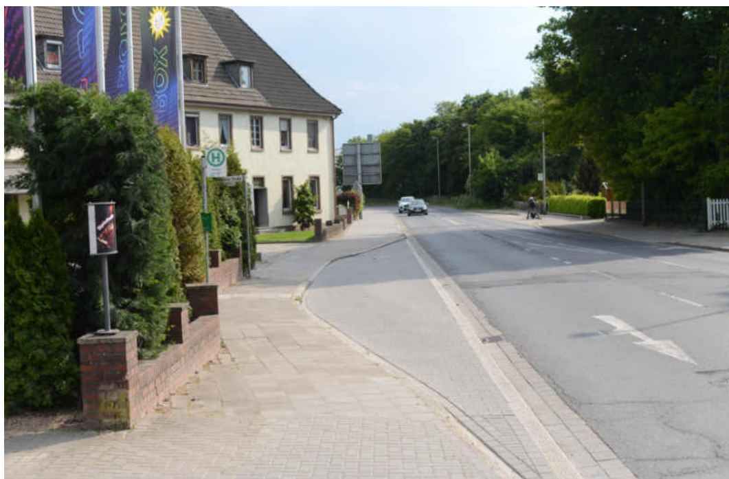
Abbildung 92 Engstelle am Zweirichtungsradweg im Bereich der Bushaltestelle Kartaus
