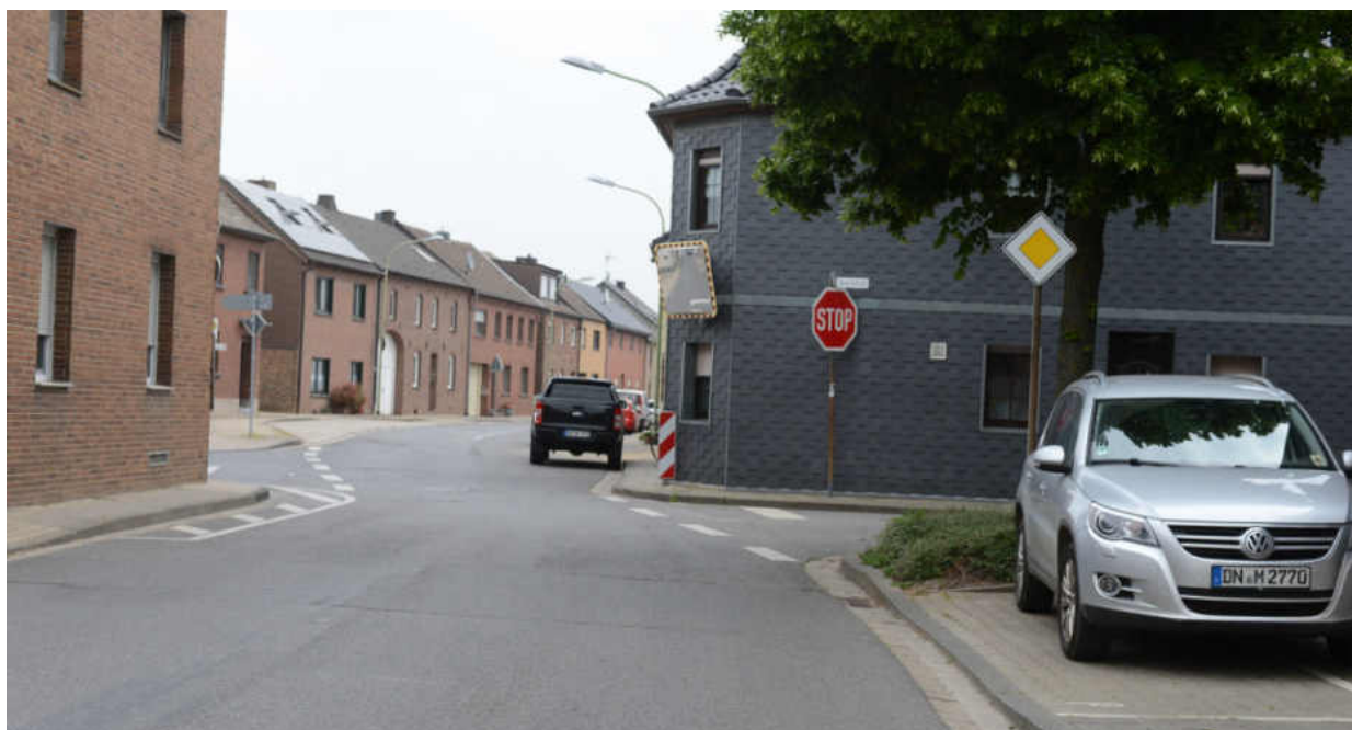
Abbildung 52: Engstelle im Straßenraum in der Welldorfer Straße (kein Schutzstreifen möglich, alternativ Absenken der zul. Höchstgeschwindigkeit?)
