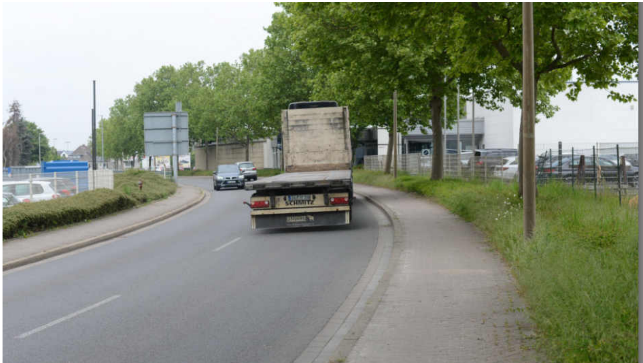
Abbildung 65: Auf dem betrachteten Abschnitt fällt beidseitig „Abstandsgrün“ jenseits der Gehwege auf. Lassen sich diese Flächen möglicherweise nutzen, um StVO-konforme Fuß- und Radwegen (Zeichen 240) mit 2,50 m Breite zu schaffen?
