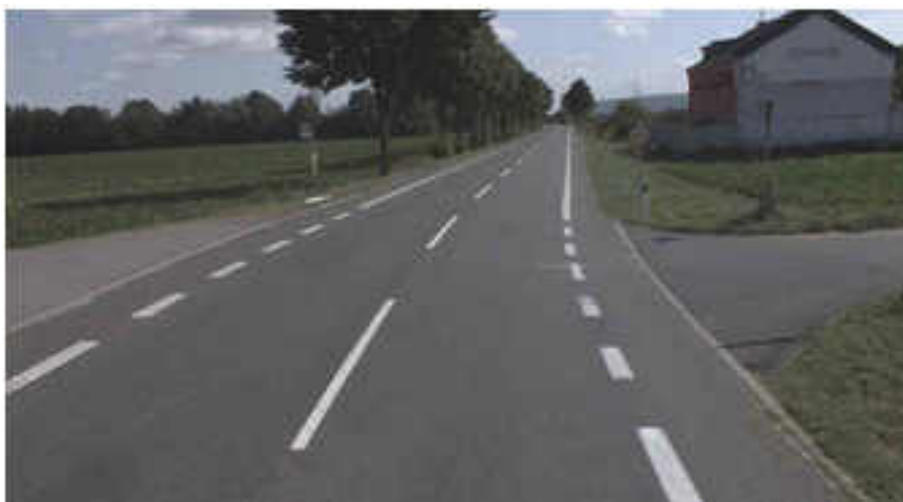
Abbildung 133: Kreuzungspunkt der Sankt-Mauri-Straße und der L 136 Aachener Landstraße. (Quelle: Bildbefahrung Landesbetrieb Straßen NRW)
