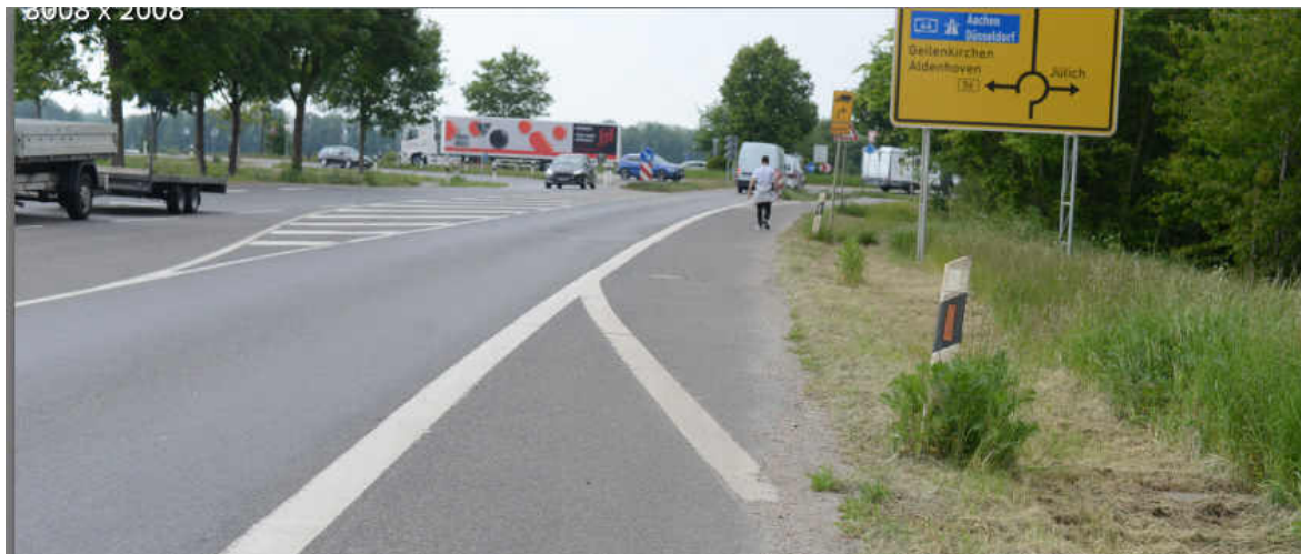
Abbildung 130: Raum für eine Separierung des Fußgänger- und Radverkehrs ist grundsätzlich vorhanden
