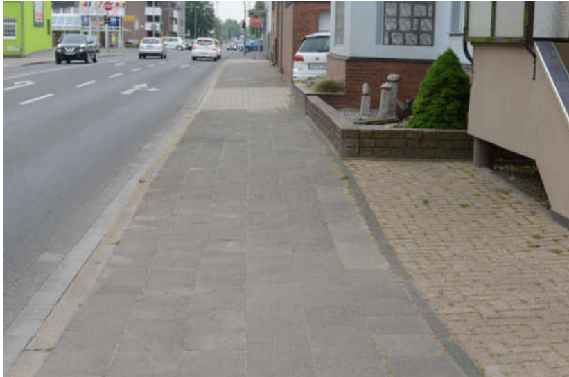
Abbildung 71: In südlicher Fahrtrichtung kann eine gemeinsame Nutzung des Gehweges mit einer Breite zwischen 1,80m und 2,40m akzeptiert werden und mit Zeichen 240 StVO ausgeschildert werden.
