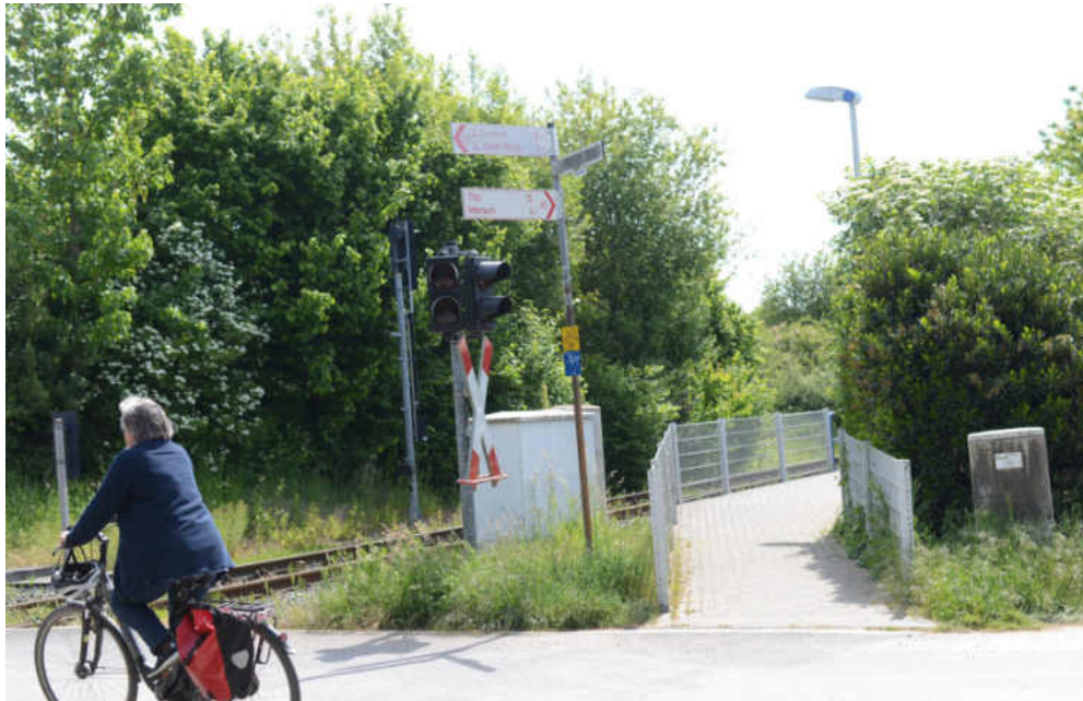
Abbildung 98: Der Wegweiser Richtung Mersch muss HINTER den Bahnübergang versetzt werden
