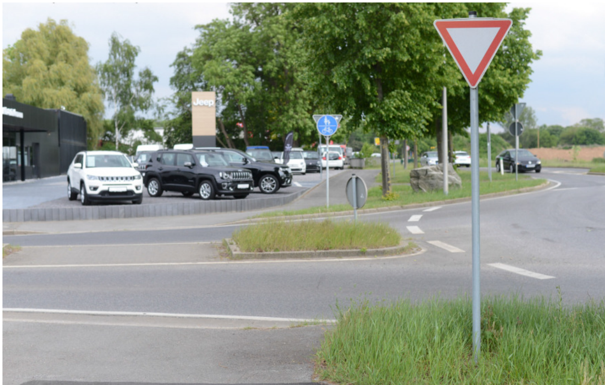
Abbildung 85: Am Kreisverkehrsplatz L 253 / Königskamp ist der Fuß- und Radverkehr dem Kfz-Verkehr untergeordnet
