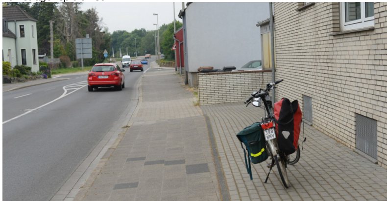
Abbildung 69: Im weiteren Verlauf ist ausreichend Raum vorhanden, um einen gemeinsamen Fuß- und Radweg auszuschildern, wenn privater Raum in Anspruch genommen wird. Im vorliegenden Fall kann ohnehin nicht regelgerecht geparkt werden.
