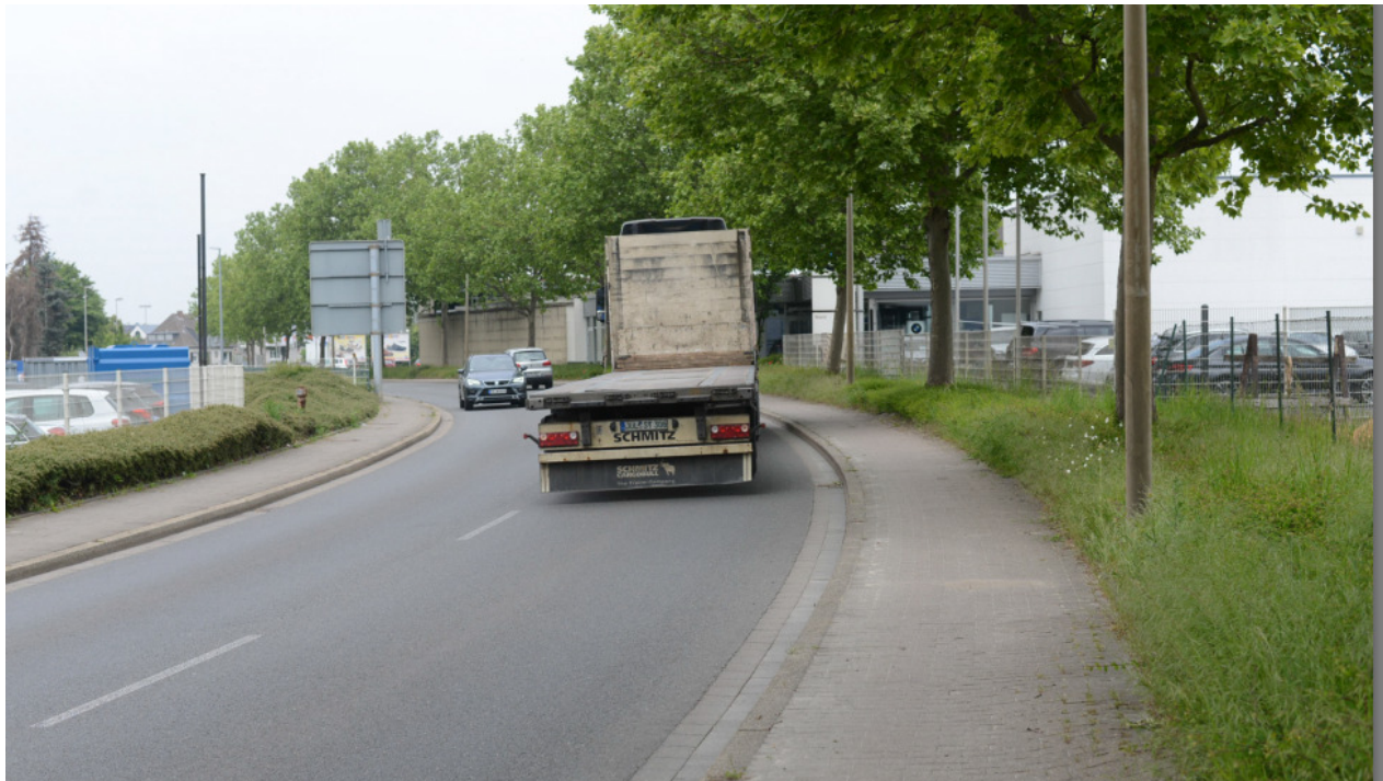
Abbildung 64: Auf dem betrachteten Abschnitt fällt beidseitig „Abstandsgrün“ jenseits der Gehwege auf. Lassen sich diese Flächen möglicherweise nutzen, um StVO-konforme Fuß- und Radwegen (Zeichen 240) mit 2,50 m Breite zu schaffen?
