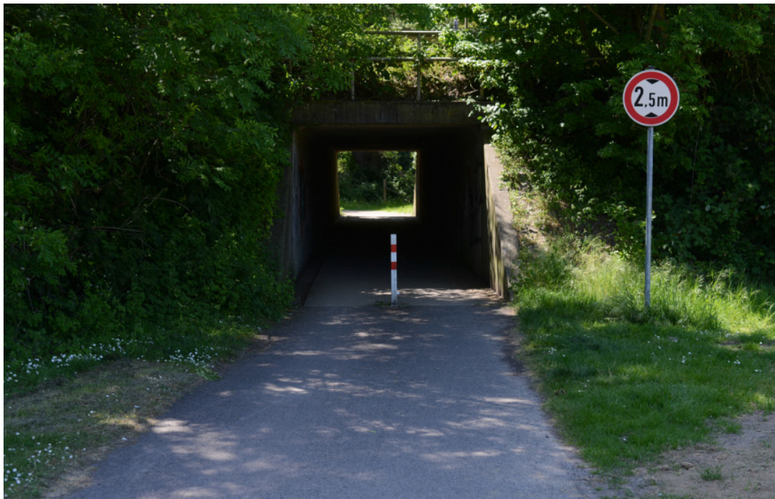
Abbildung 100: Die Unterführung stellt einen Bereich der subjektiven Unsicherheit dar. Die Verkehrssicherheit ist aufgrund der Sichtverhältnisse ebenfalls nicht gewährleistet
