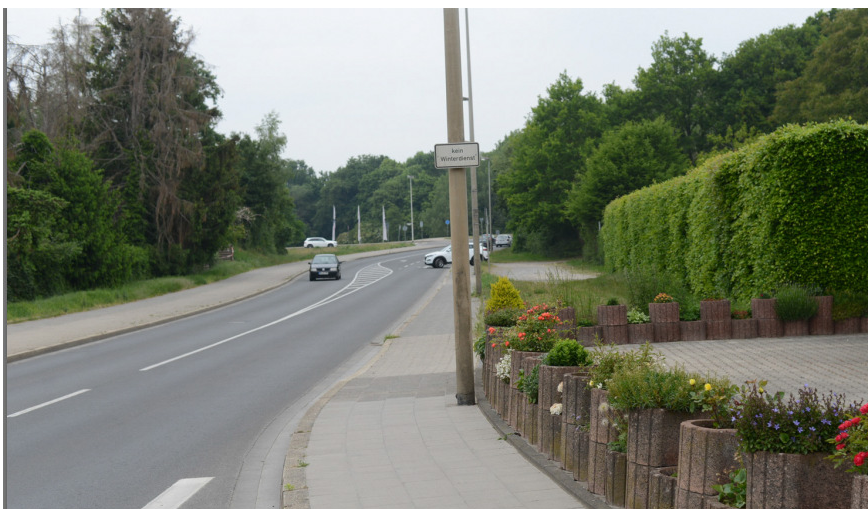
Abbildung 72: Auf der östlichen Straßenseite ist eine Verbreiterung der Nebenanlage auf 2,50m anzustreben und eine durchgehende Radverkehrsanlage zu schaffen.
