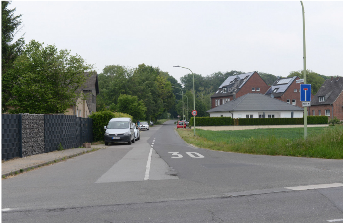
Abbildung 53: Fehlender Zusatz „Durchlässig für Fußgänger und Radfahrer“ am Zeichen 357 StVO
