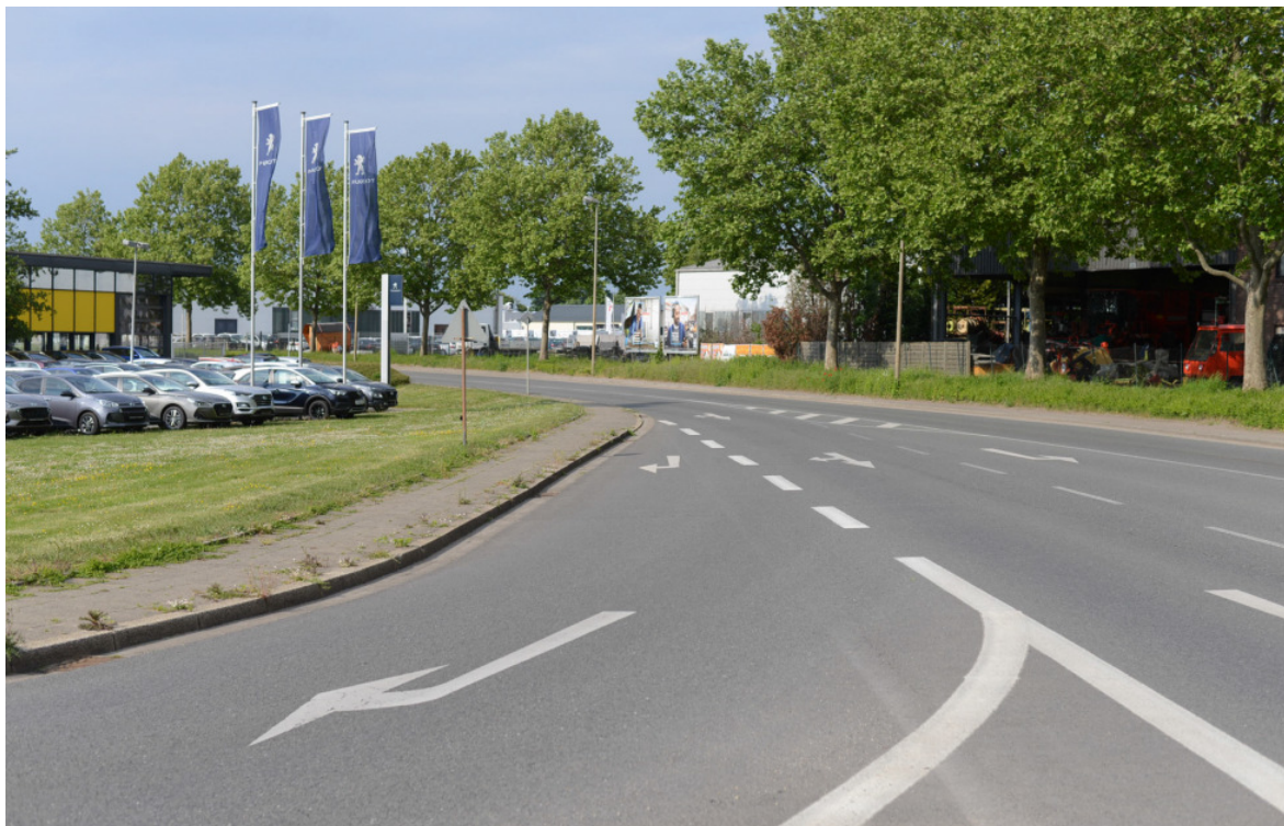
Abbildung 65: Unklare Führung des Radverkehrs über den freien Rechtsabbieger (von der Oststraße kommend)
