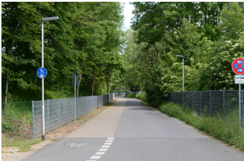
Abbildung 80: Gemeinsamer Fuß- und Radweg mit unklarer Abgrenzung zur Fahrbahn (kein Fahrbahnbegrenzungstreifen, kein Bordstein)
