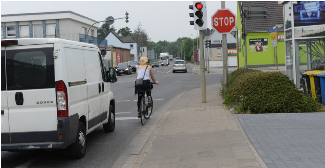
Abbildung 58: Es ist eine nicht zufriedenstellende Situation durch nicht ausreichende Abstände zwischen den Verkehrsteilnehmern zu erkennen. Auch hier wäre im Bereich des Begleitgrüns Raum für eine deutliche Verbreiterung der Nebenanlagen vorhanden
