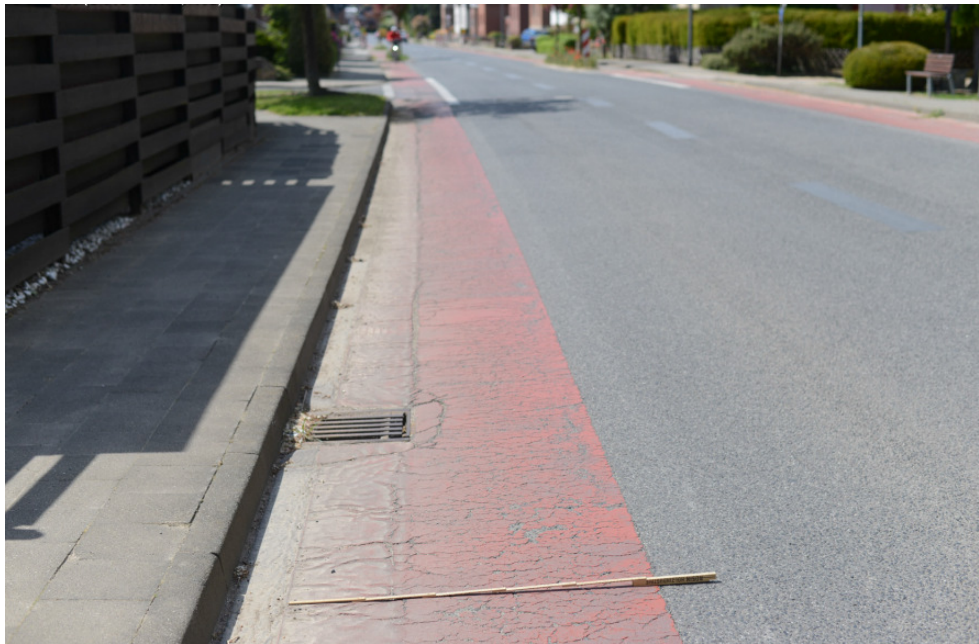
Abbildung 77: Markierung und Breite nicht StVO-konform
