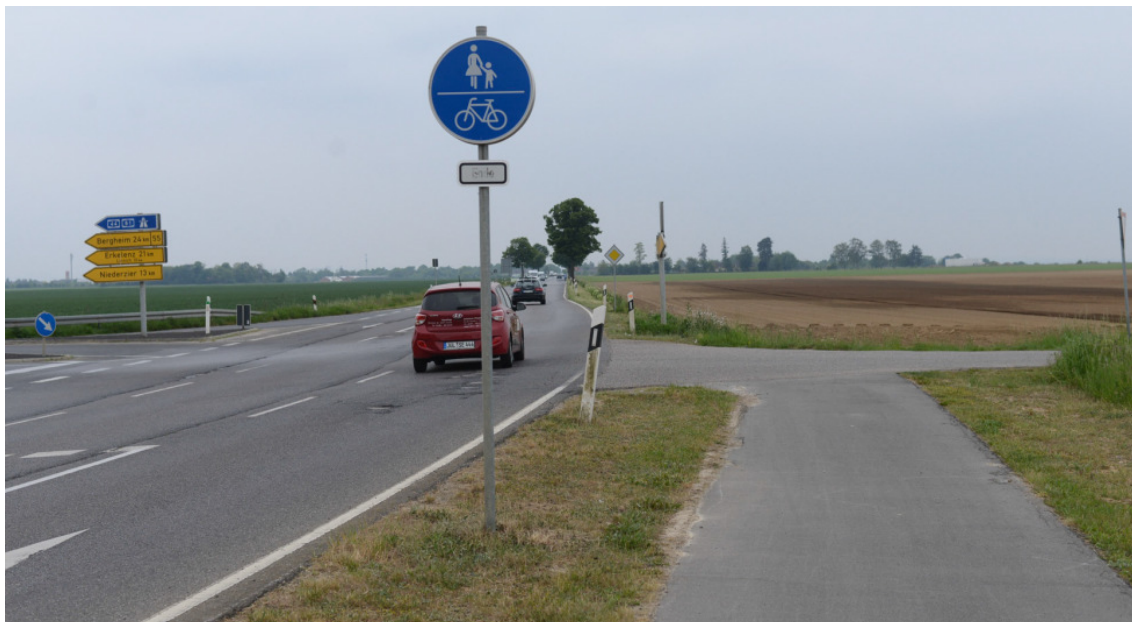
Abbildung 42: Ende des vorhandenen Fuß- und Radweges an der L241 am Knotenpunkt mit der Rampe zur B55
