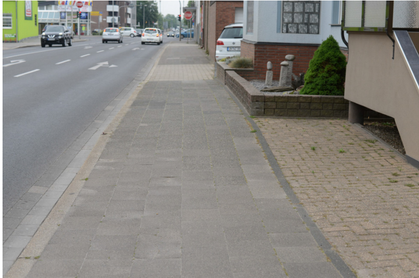
Abbildung 70: In südlicher Fahrtrichtung kann eine gemeinsame Nutzung des Gehweges mit einer Breite zwischen 1,80m und 2,40m akzeptiert werden und mit Zeichen 240 StVO ausgeschildert werden.
