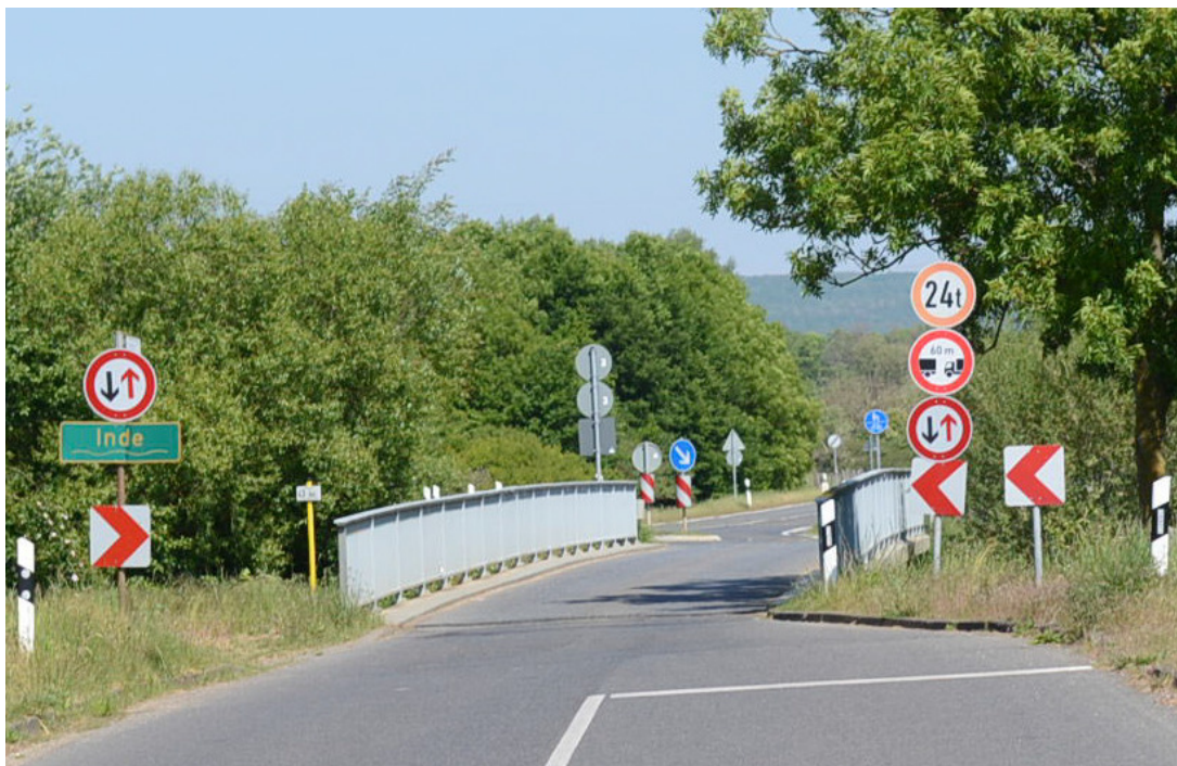
Abbildung 102: Beginn des Radweges hinter der Indequerung
