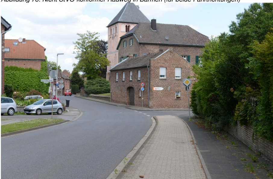
Abbildung 79: Der Bewuchs ist zu entfernen, der Beschilderungsposten sollte nicht im Bewegungsraum der Fußgänger und Radfahrer stehen
