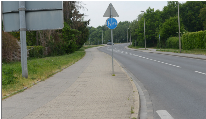
Abbildung 71: Die westliche Nebenanlage ist mit 2,30m für den Zweirichtungsradweg und 1,50m für den Fußgängerweg nicht regelkonform, kann aber so beibehalten werden, damit die querungsfreie Verbindung zwischen Mariengartenstraße und An der Leimkaul erhalten bleibt
