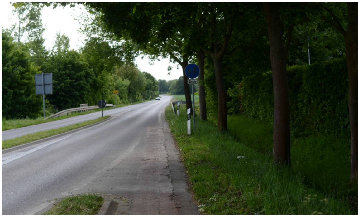
Abbildung 92: Fehlende Radverkehrsanlagen an der Kreisstraße K 6
