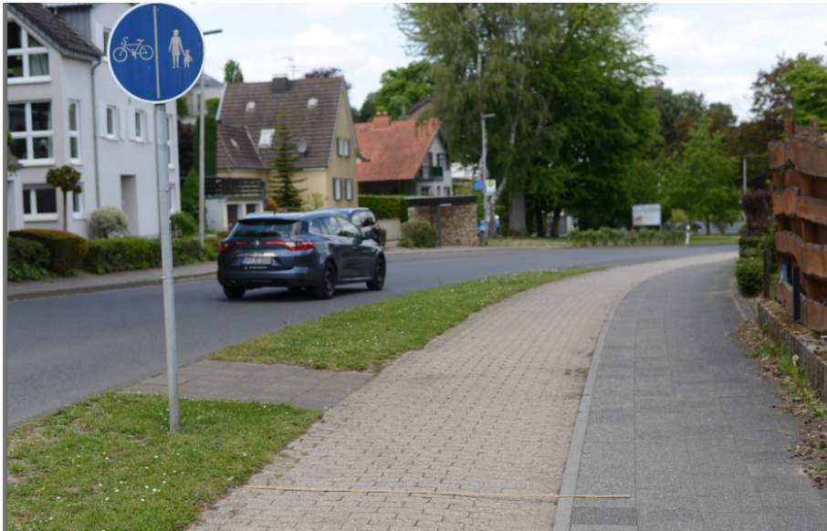
Abbildung 78: Nicht StVO-konformer Radweg in Barmen (für beide Fahrrichtungen)
