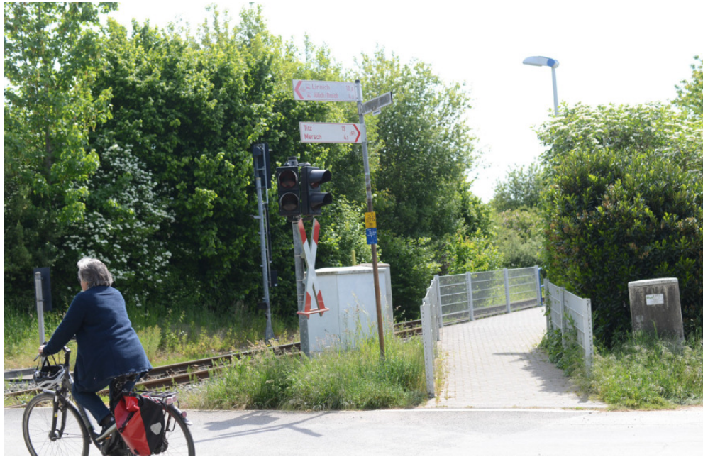
Abbildung 97: Der Wegweiser Richtung Mersch muss HINTER den Bahnübergang versetzt werden
