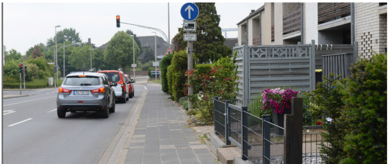
Abbildung 62: Auch am Knotenpunkt mit der Alten Dürener Straße zeigt sich der Fußweg mit seiner Regelbreite von 1,50 m
