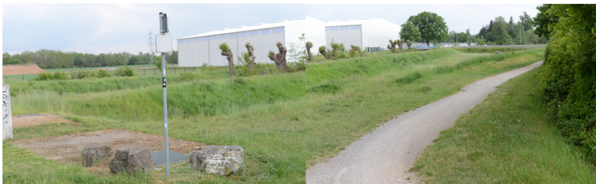
Abbildung 88: Wassergebundene Decke mit ausgebliebenem „Wiederholer“ des Radverkehrsnetz NRW
