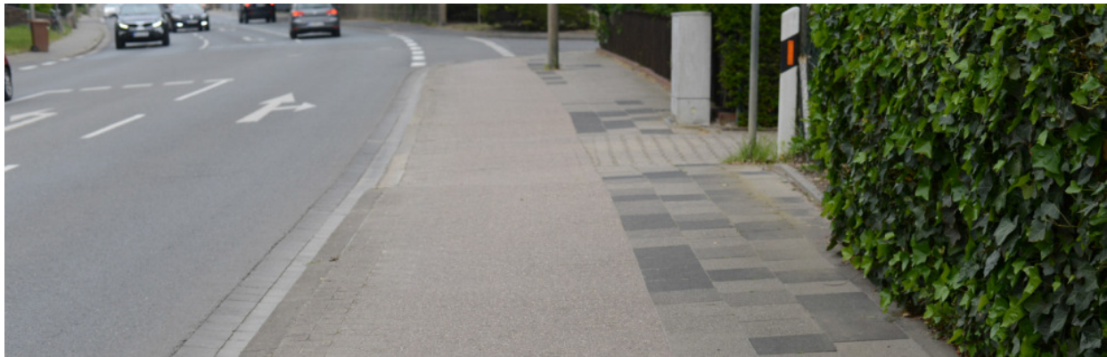
Abbildung 63: Nur am östlichen Straßenrand zwischen Alter Dürener Straße und Buchenstraße ist ein 1,50 m breiter Radweg und ein Fußweg von ca. einem Meter Breite vorhanden
