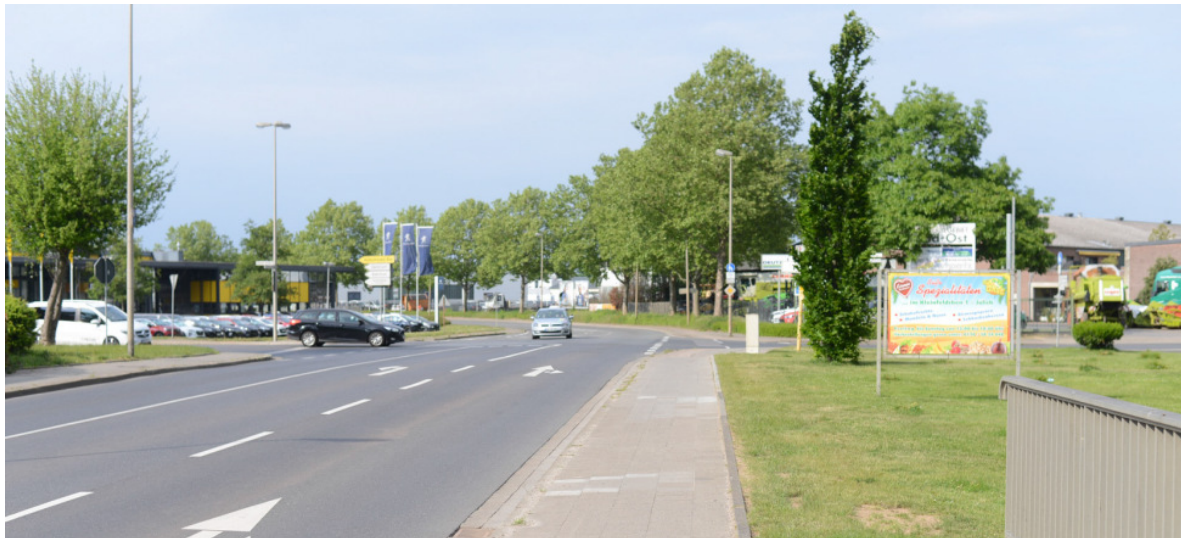
Abbildung 66: Von Süden kommend muss von der Dürener in die Dürener Straße indirekt abgelenkt werden. Es gibt keine Hilfen, Aufstellflächen oder Ähnliches.
