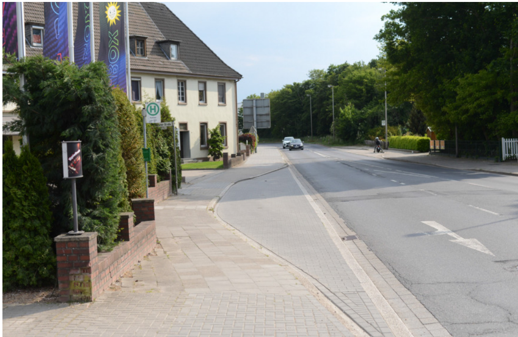
Abbildung 91 Engstelle am Zweirichtungsradweg im Bereich der Bushaltestelle Kartaus
