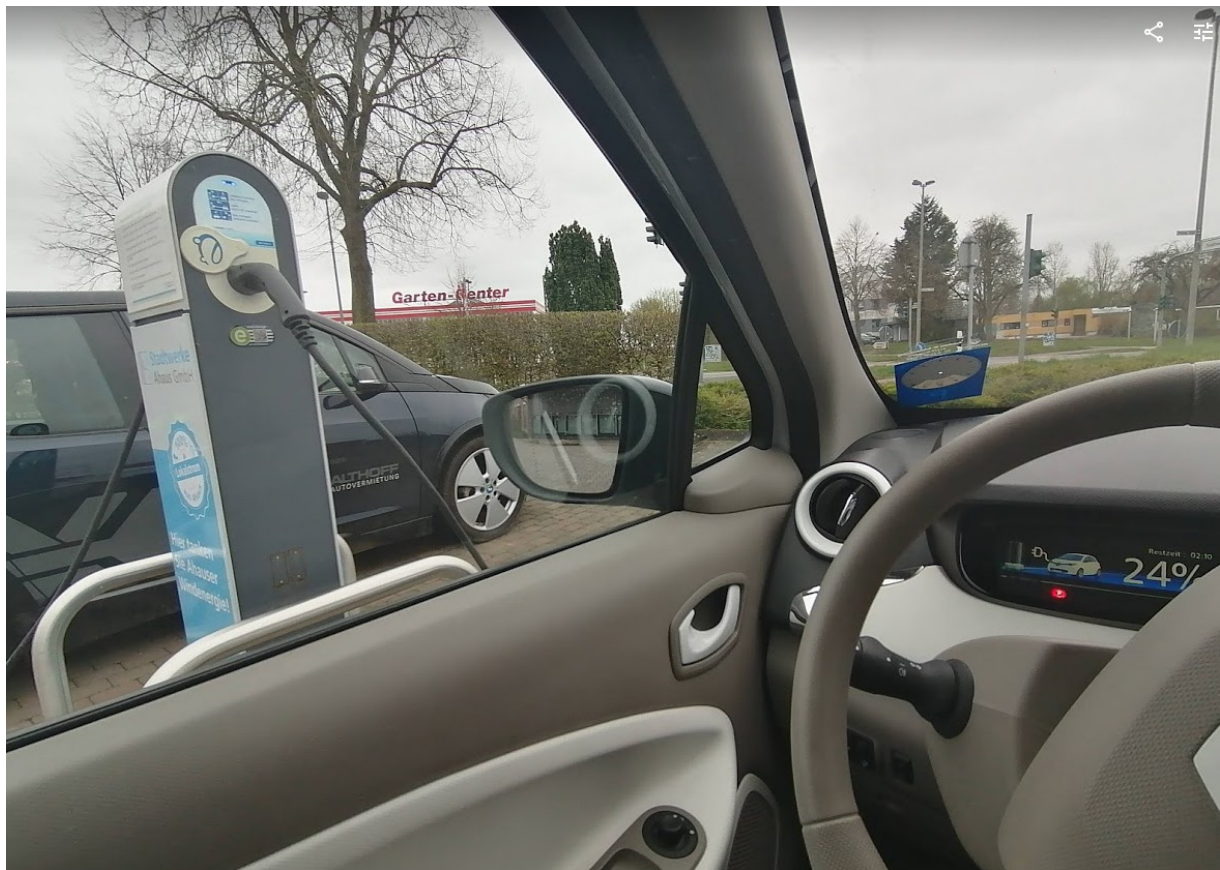
Abbildung 19: Laden an einer öffentlichen Ladesäule mit Wechselstrom (AC) und einer Leistung von bis zu 22 kW
