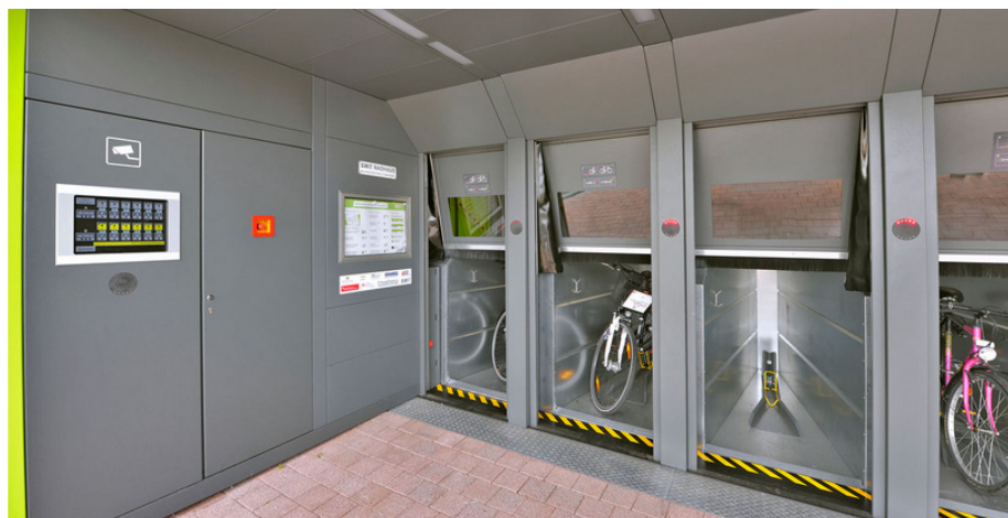
Abbildung 11: Fahrradabstellanlage Offenburg, Aufzüge zur Abstellung der Fahrräder, Quelle: NVR
